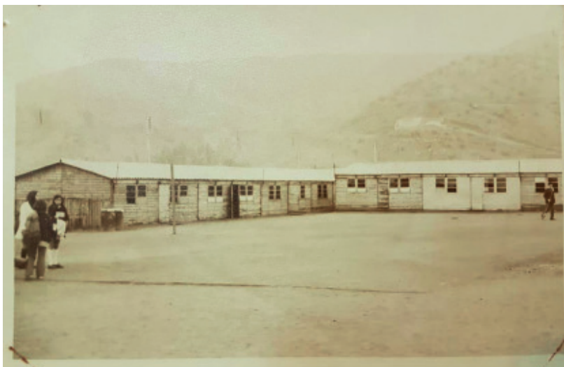
Imagen 6: Escuela Carlos Prats González. Salas de emergencia, año 1970. Fotografía de propiedad de Carlos Castro Pacheco. Citada en Nahuelpán y Saavedra (2019, p. 49).
